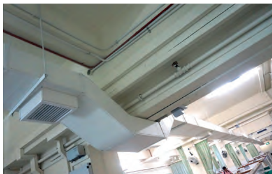
Ventilation ducting system at the ceiling 天花板上的通风管道系统
